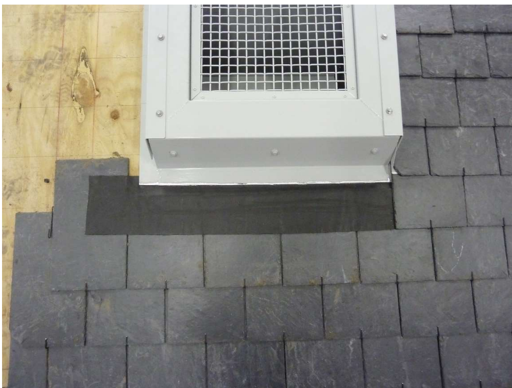
Loodvervangende slabbe
