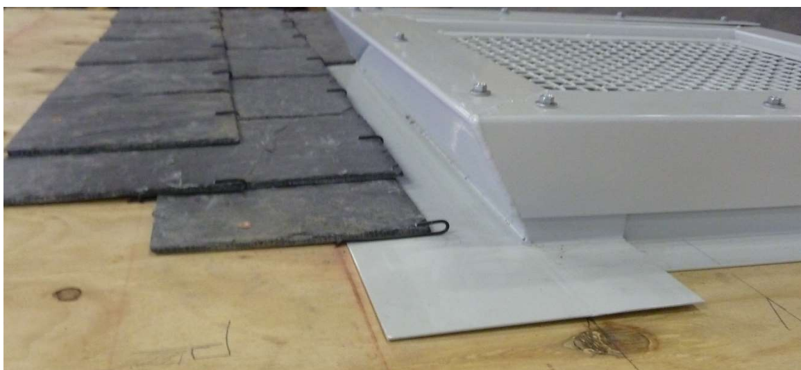
Aansluiting leien op boven loket
