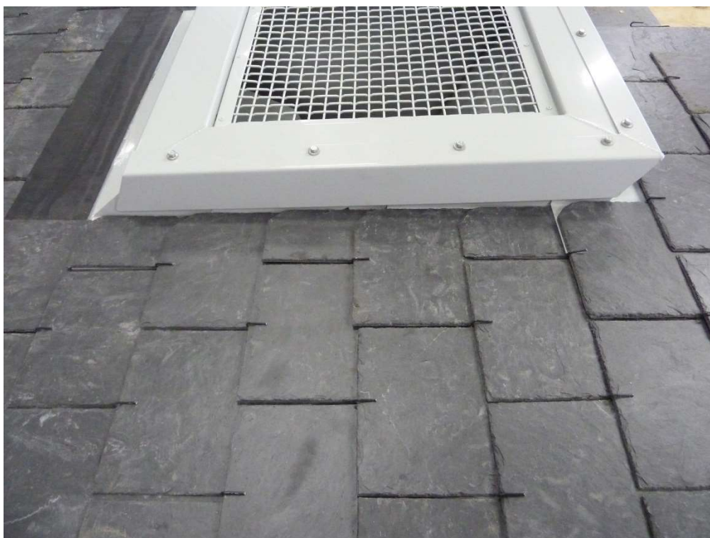
Aansluiting leien aan zijkant met ingewerkte loketten
